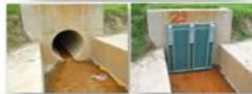
Antes y después de la Instalación de una Válvula antirreflujo
