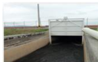
Bombeo de respaldo Estación Fontibón – Capacidad 2x0.5 m 3 /sg
