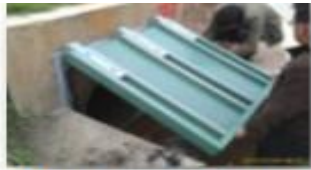
Válvula antirreflujo tipo A – Instaladas en las Localidades de Bosa y Kennedy
