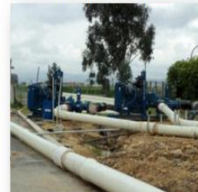
Bombeo de respaldo Estación Fontibón – Capacidad 2x0.5 m 3 /sg
