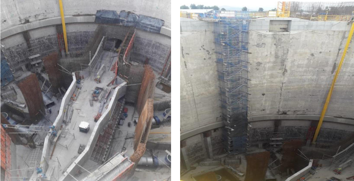
Imagen 3. Pozo de succión y/o bombeo-septiembre 28 de 2022
