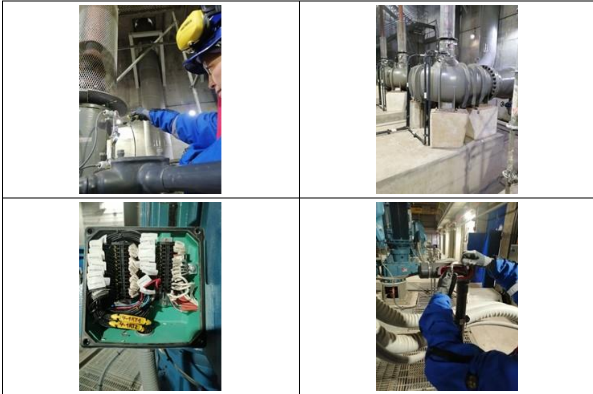
Fotografía 31. Mantenimiento preventivo a bomba de agua cruda 053P002D
