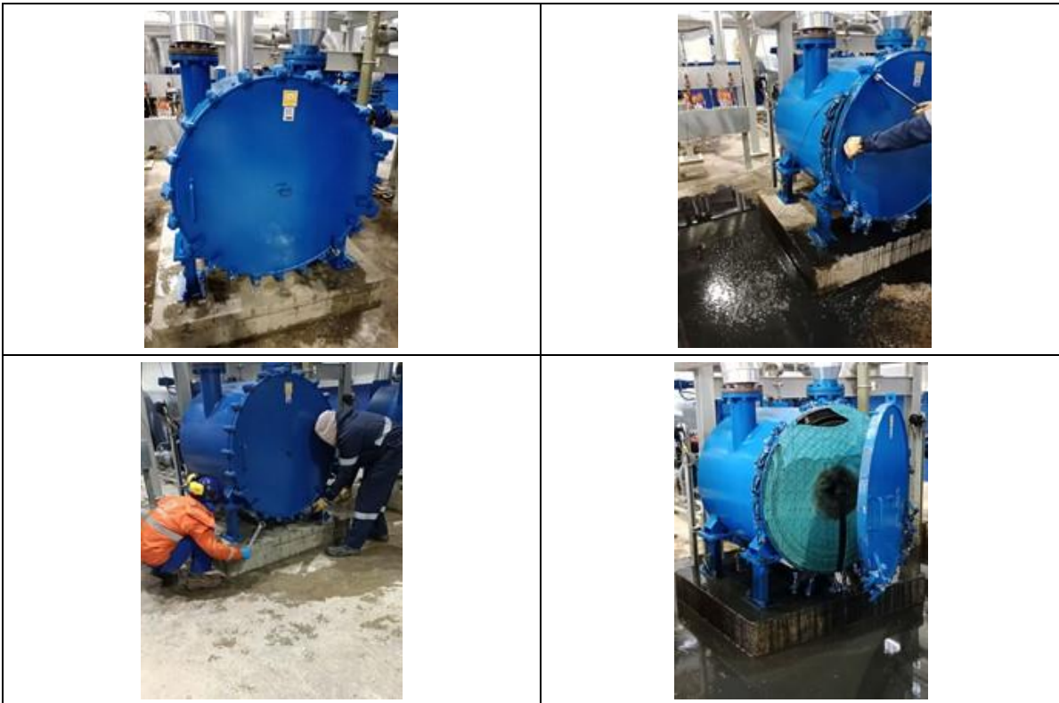
Fotografía 12. Mantenimiento reja automática en canal cribado grueso
