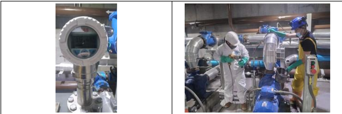
Fotografía 19. Mantenimiento instrumentos de presión 091PIT1012D/E/F y 091PI112D/E/F
