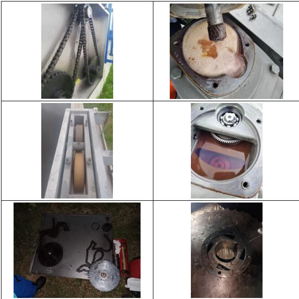
Fotografía 9. Mantenimiento preventivo puentes clarificadores secundarios
