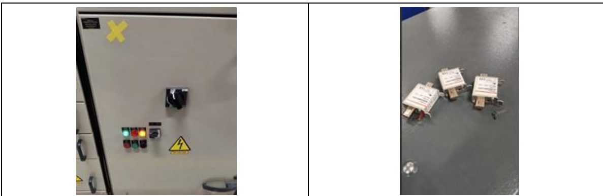
Fotografía 15. mantenimiento bomba 095P201B
