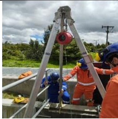
Ingreso al edificio de elevación de agua lluvia
