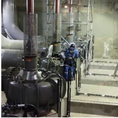
Actividades de mantenimiento Elevación de aguas fase II
