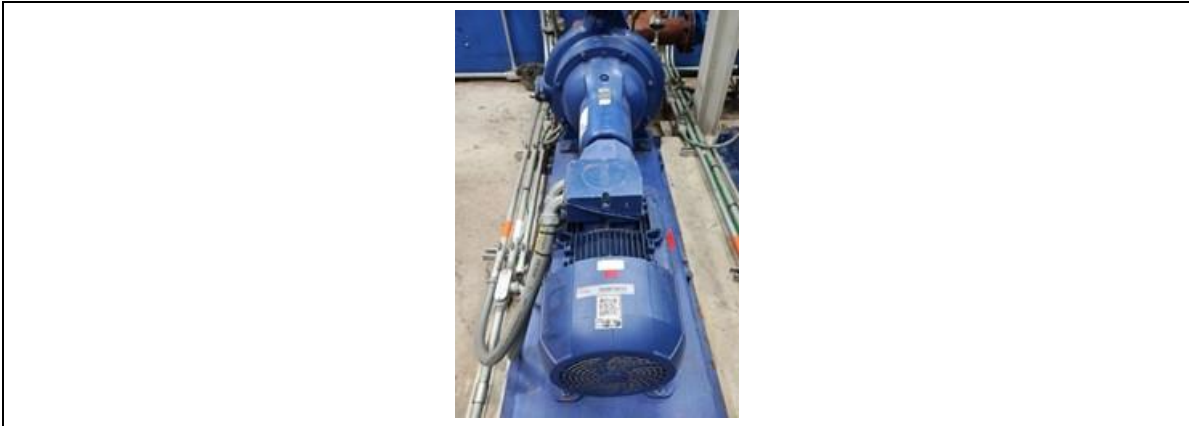
Fotografía 17. mantenimiento preventivo bombas de los edificios de bombeo de lodos y flotantes
