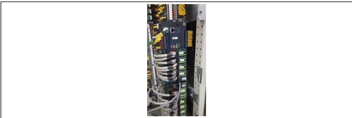
Fotografía 25. Mantenimiento PLC del lado B del CCM9
