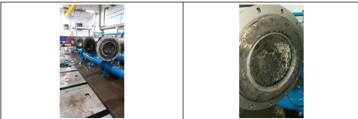
Fotografía 10. Mantenimiento filtros de aguas de servicio
