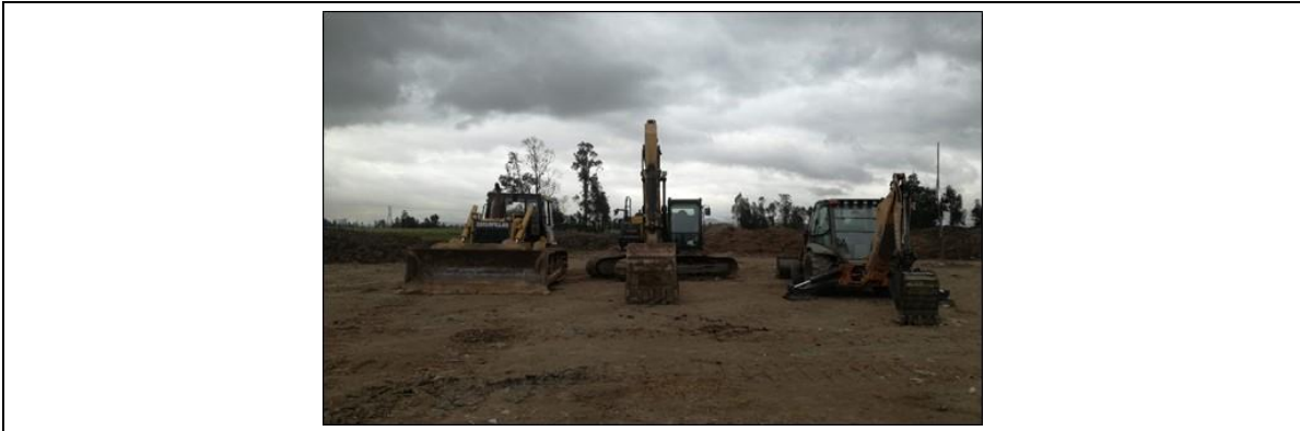
Fotografía 4. Maquinaria empleada en el patio de secado retroexcavadora de llanta tipo pajarita y el predio la Magdalena bulldozer y excavadora de oruga
