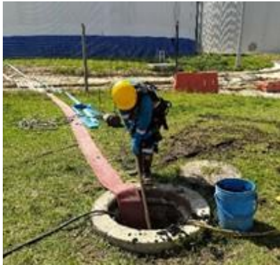
Se ejecutan actividades de limpieza
