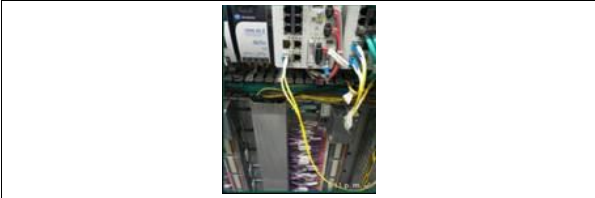
Fotografía 19. cambio de fibra óptica de los switch de comunicaciones
