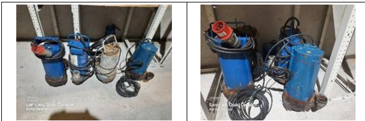
Fotografía 13. Mantenimiento bombas de achique
