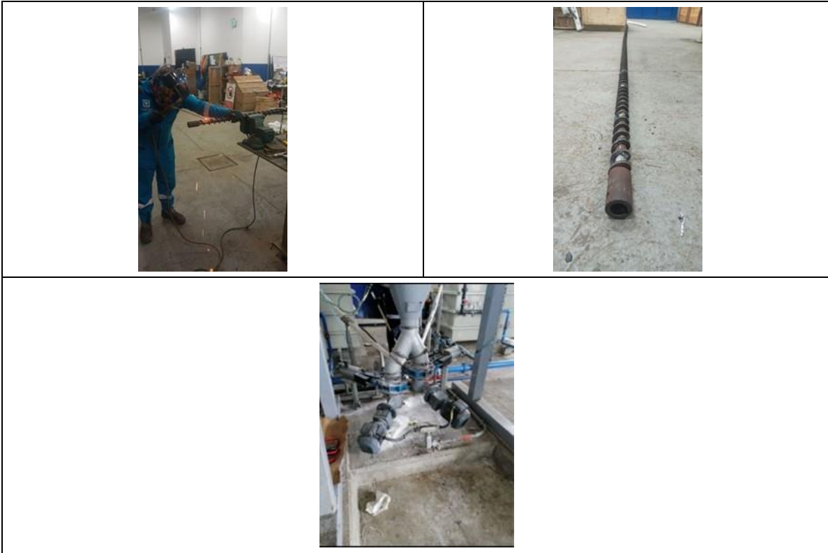
Fotografía 9. Mantenimiento preparador de polímero 074T001A
