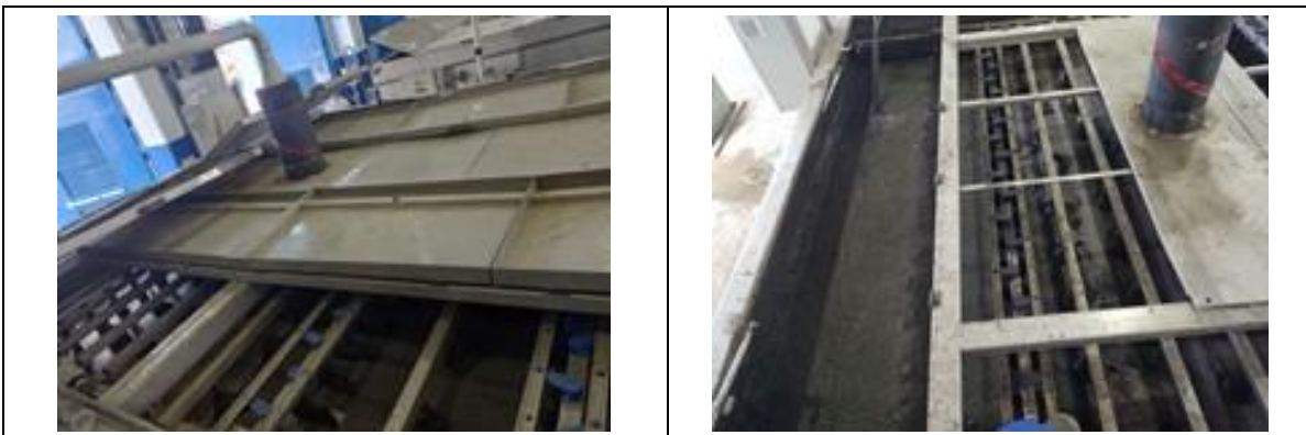
Fotografía 20. Mantenimiento mesas espesadoras 076DEP001E y 076DEPO01A
