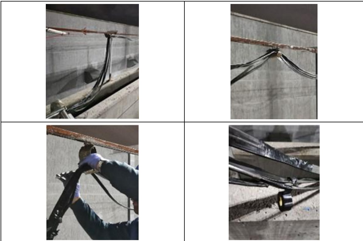
Fotografía 13. Mantenimiento puente desarenador 054DSB001A
