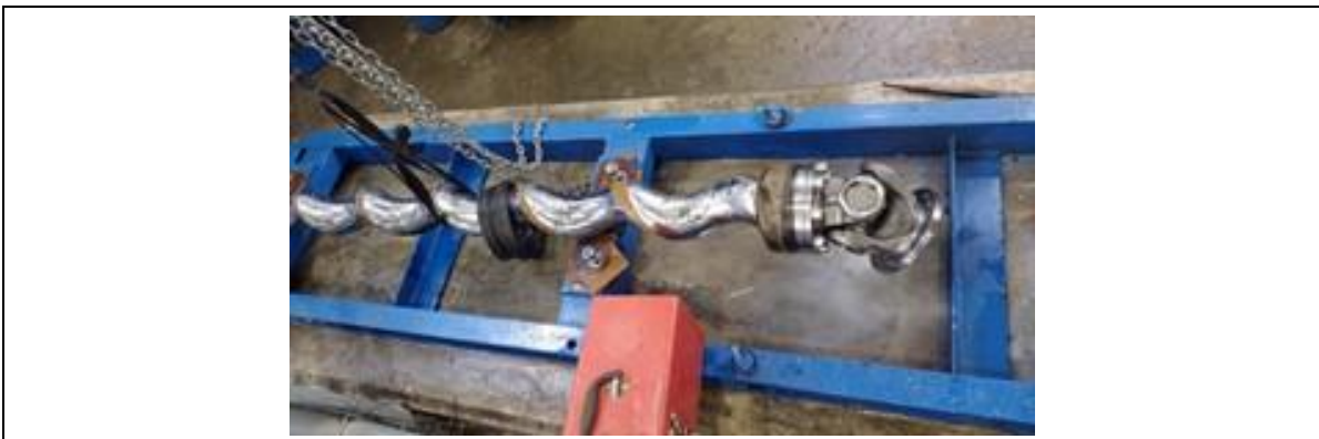
Fotografía 19. Mantenimiento bombas 073P002A y 073P001A.
