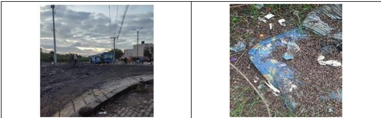
Fotografía 31. Problemática evidenciada en las barreras 5 y 6 de la PTAR El Salitre: Disposición inadecuada de basuras y afectación de los individuos arbóreos
