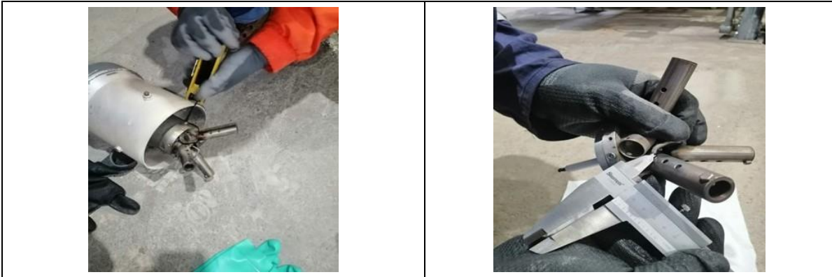
Fotografía 12. mantenimiento calderas 111ECA001A/E
