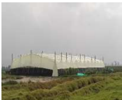
Vista general de la cubierta de secado
