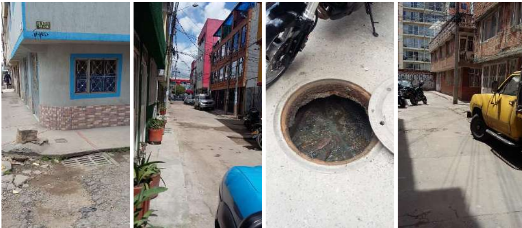
Figura 87. Soporte fotográfico diagnóstico de existencia y/o estado de redes de alcantarillado sanitario.
