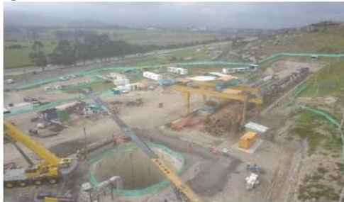
Figura 94. Avance del sistema de interceptores del Río Bogotá.
