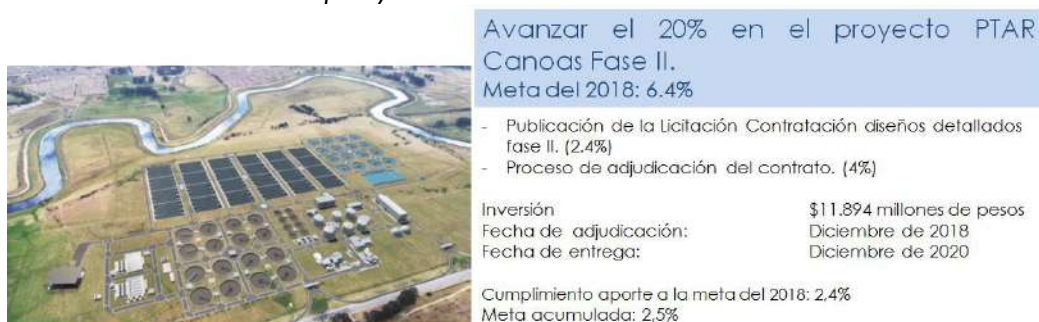
Figura 96. Avance en el proyecto PTAR Canoas Fase II.
