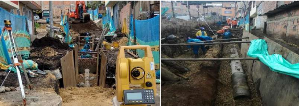
Figura 88. Soporte fotográfico construcción de redes locales de alcantarillado sanitario.
