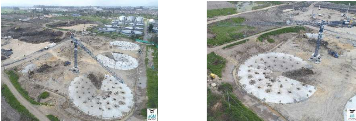
Figura 106. Avance de obra ampliación PTAR Salitre Fase II:
