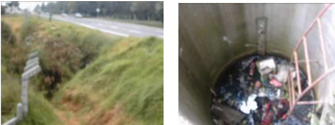
Figura 80. Llegada de la quebrada Torca a la Autopista Norte y estructura para control de caudal en el separador. (Fuente Fotografía: EAAB – ESP)
