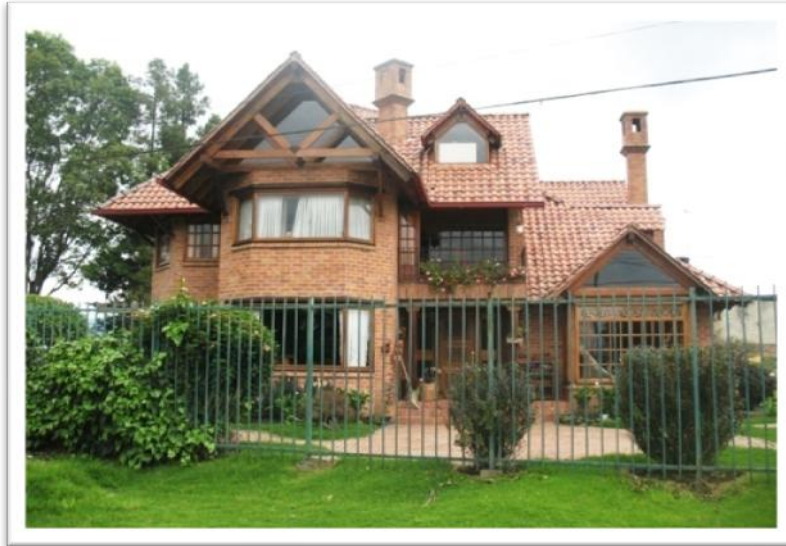
Figura 103. Tipo de vivienda campesina, en la Parcelación El Jardín, del Área de Influencia Directa del Humedal Guaymaral. (Fuente: Fotografía tomada en marzo 2009 por Gloria S. Moreno F)
