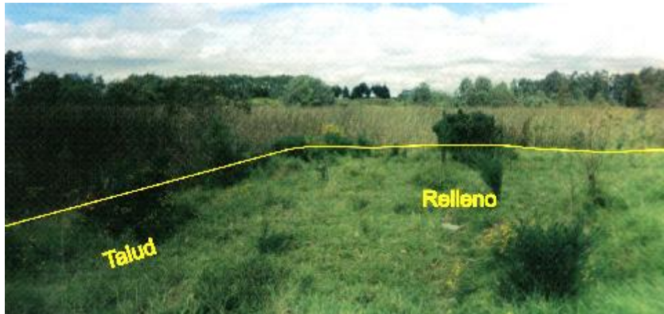
Figura 37. Transiciones de talud a terraza baja por relleno en el borde norte de Guaymaral. (Fuente: Archivo fotográfico IDEA)
