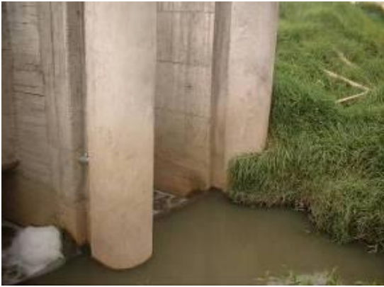
Figura 49. Estructura de entrada a la alcantarilla contigua a Cafam (Fuente: EAAB-ESP)
