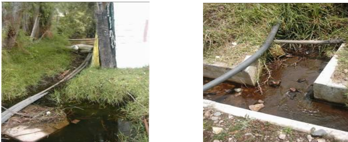
Figura 75. Desección de las zonas de recarga en predios al borde de la vía férrea a altura de la 237, vecinos al antiguo club Bavaria (coordenadas X=1004832, Y=1532373). (Fuente Fotografía: EAAB – ESP)
