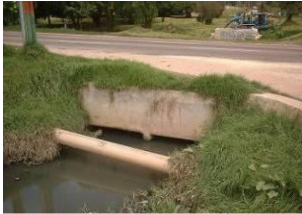
Figura 53. Salida de la alcantarilla calle 222 (Humedal Guaymaral) (Fuente: EAAB-ESP)
