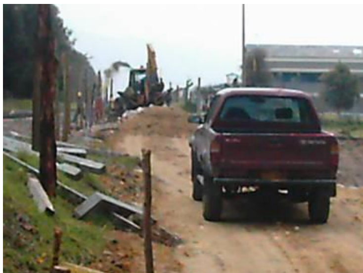
Figura 78. Personal de la EAAB-ESP en obra de readecuación en la vía paralela a la línea férrea en el cruce con la quebrada Torca (coordenadas X=1004856,Y=1531961) (Fuente Fotografía: EAAB – ESP)
