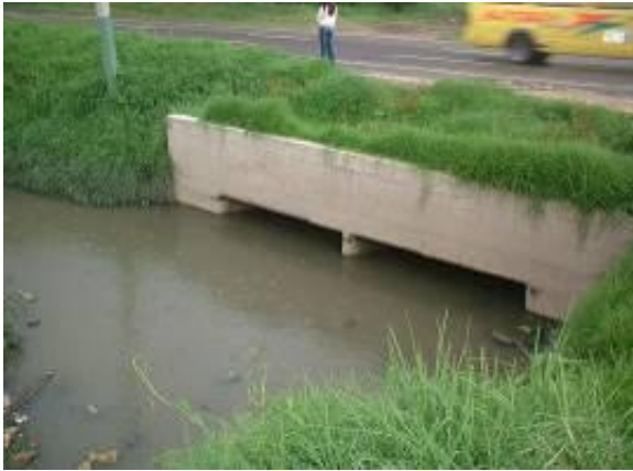
Figura 52. Entrada a la alcantarilla calle 222 (Humedal Torca) (Fuente: EAAB-ESP)
