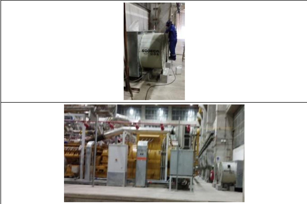
Fotografía 19. mantenimiento moto ventiladores sala moto generadores
