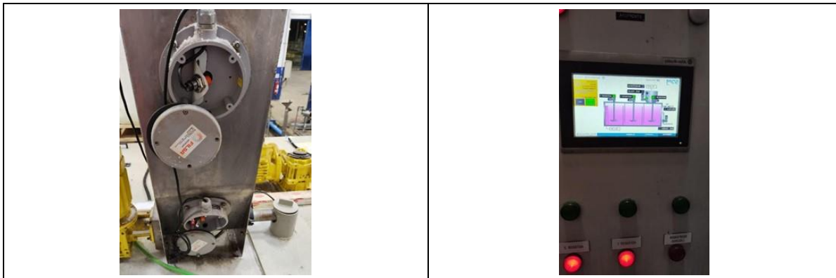
Fotografía 25. mantenimiento sensores de nivel skid de preparación de polímero 074QP101A
