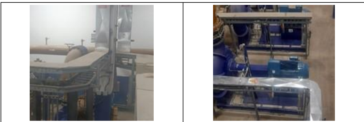
Fotografía 17. mantenimiento bandejas porta cables edificios des RAS/WAS
