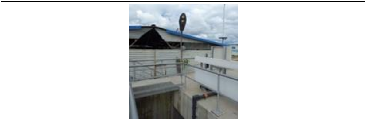
Fotografía 16. Instalacion luminarias en la zona de aguas pluviales
