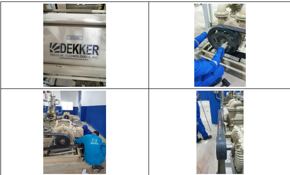
Fotografía 11. Mantenimiento compresor PTAR fase II
