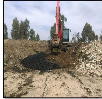
Labores de mezcla Aprovechamiento predio la magdalena celda 3, metodología 3:1
