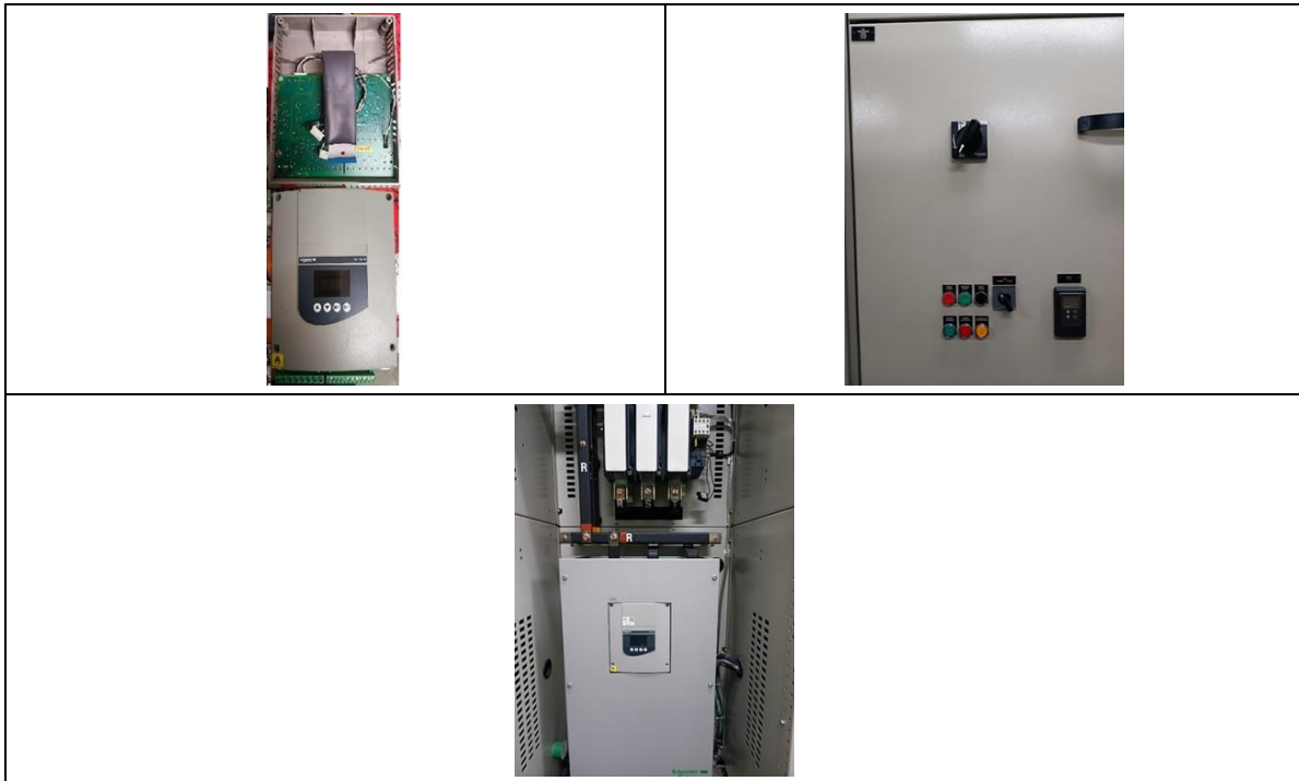
Fotografía 13. Mantenimiento motor tornillo 01P01E
