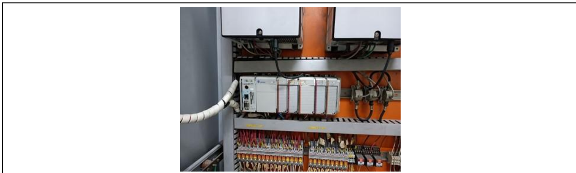
Fotografía 14. Mantenimiento PLC edificio agua potable
