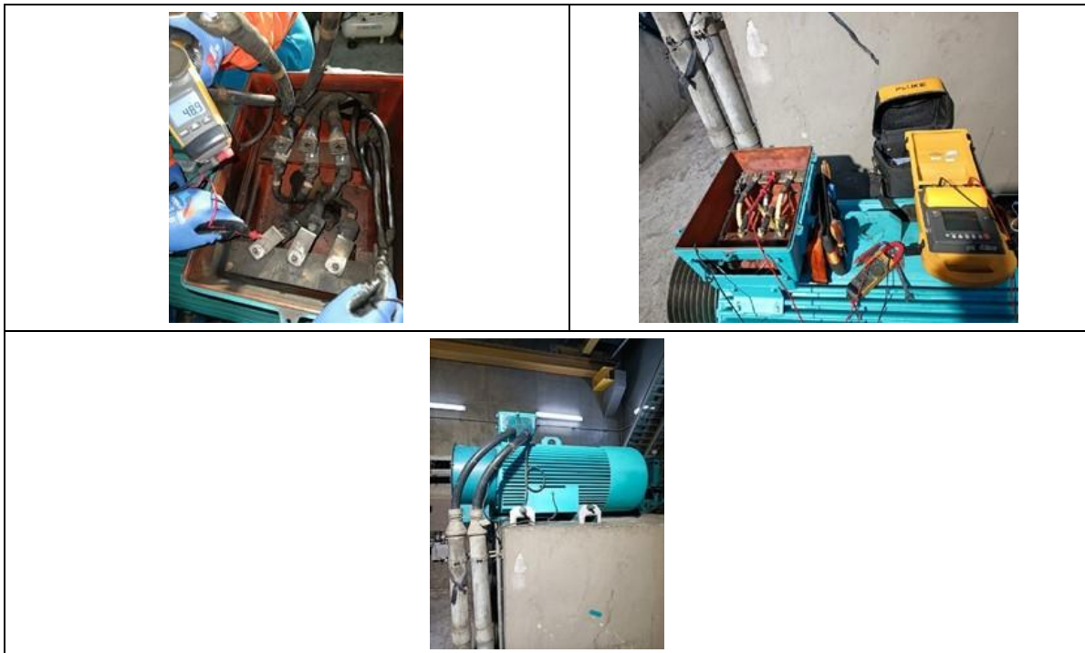
Fotografía 12. Mantenimiento motor tornillo 01P01A
