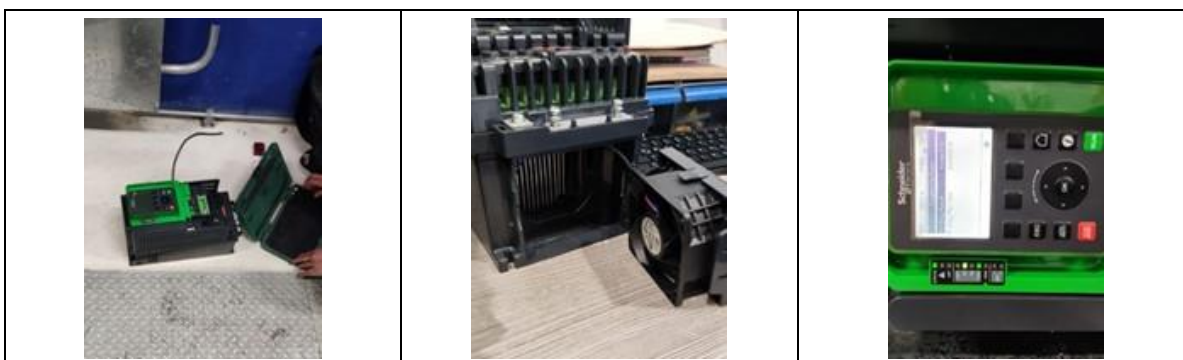
Fotografía 6. Mnatenimiento Variador bomba de lodos a espesadores de banda por gravedad 090P101A
