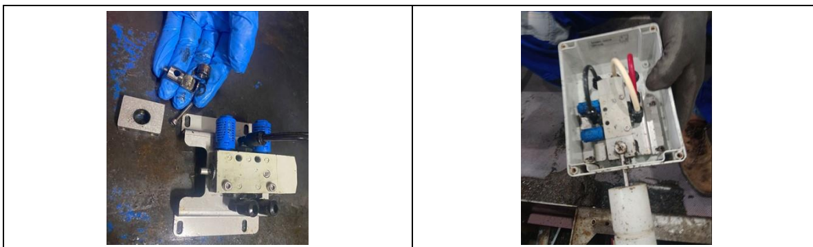
Fotografía 15. Mantenimientos espesador de banda por gravedad-GBT N°5 076DEP001E
