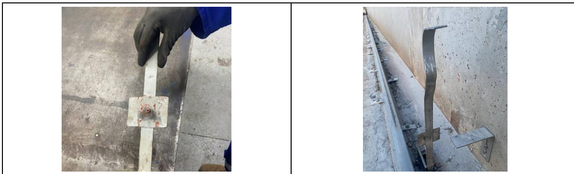
Fotografía 14. Mantenimiento puente desarenador N°1 054DSB001A
