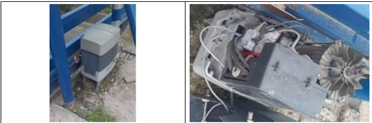
Fotografía 13. Mantenimiento motor puerta principal
