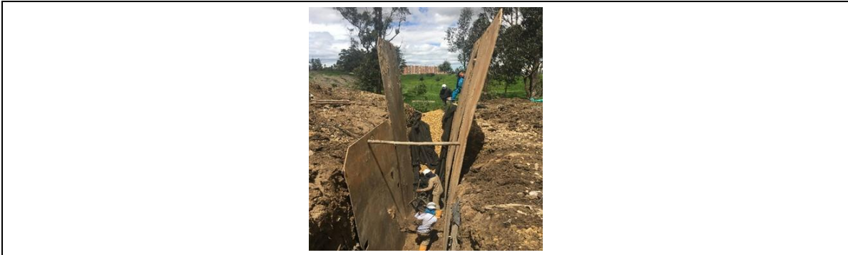
Fotografía 2. Suministro de Grava 1 ½"
