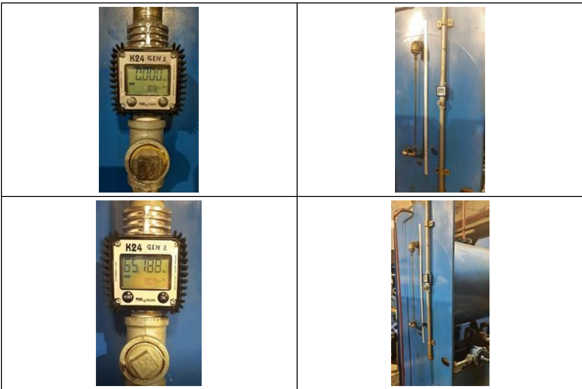
Fotografía 11. Cambio medidores tanque ACPM generadores
