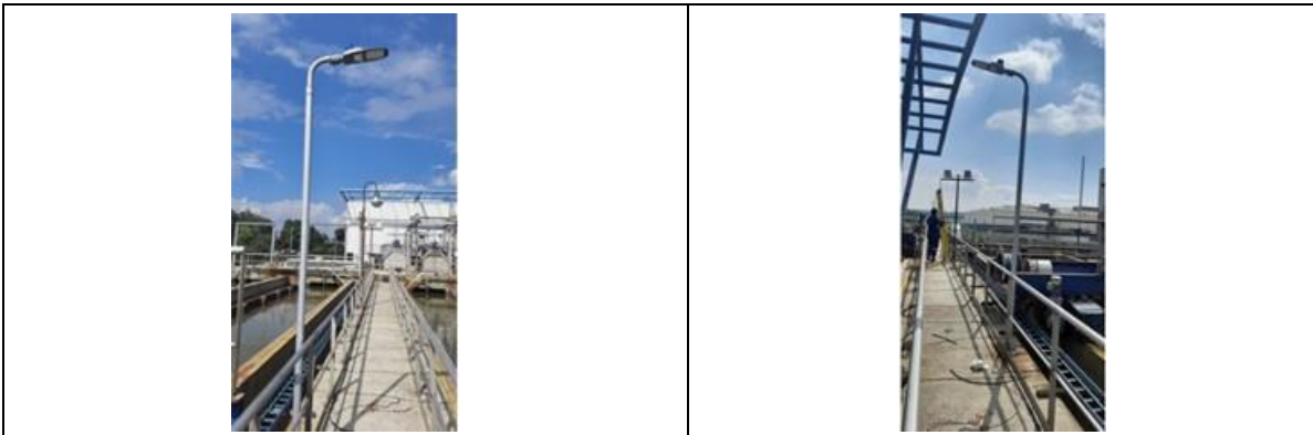
Fotografía 10. Cambio de iluminación interna edificios PTAR
