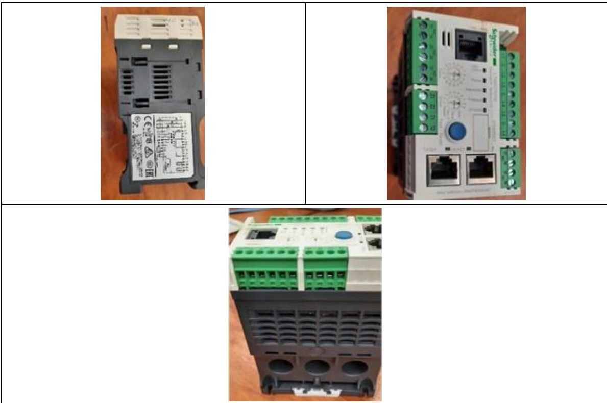
Fotografía 16. Mantenimiento TESYST El puente decantador 4.1
