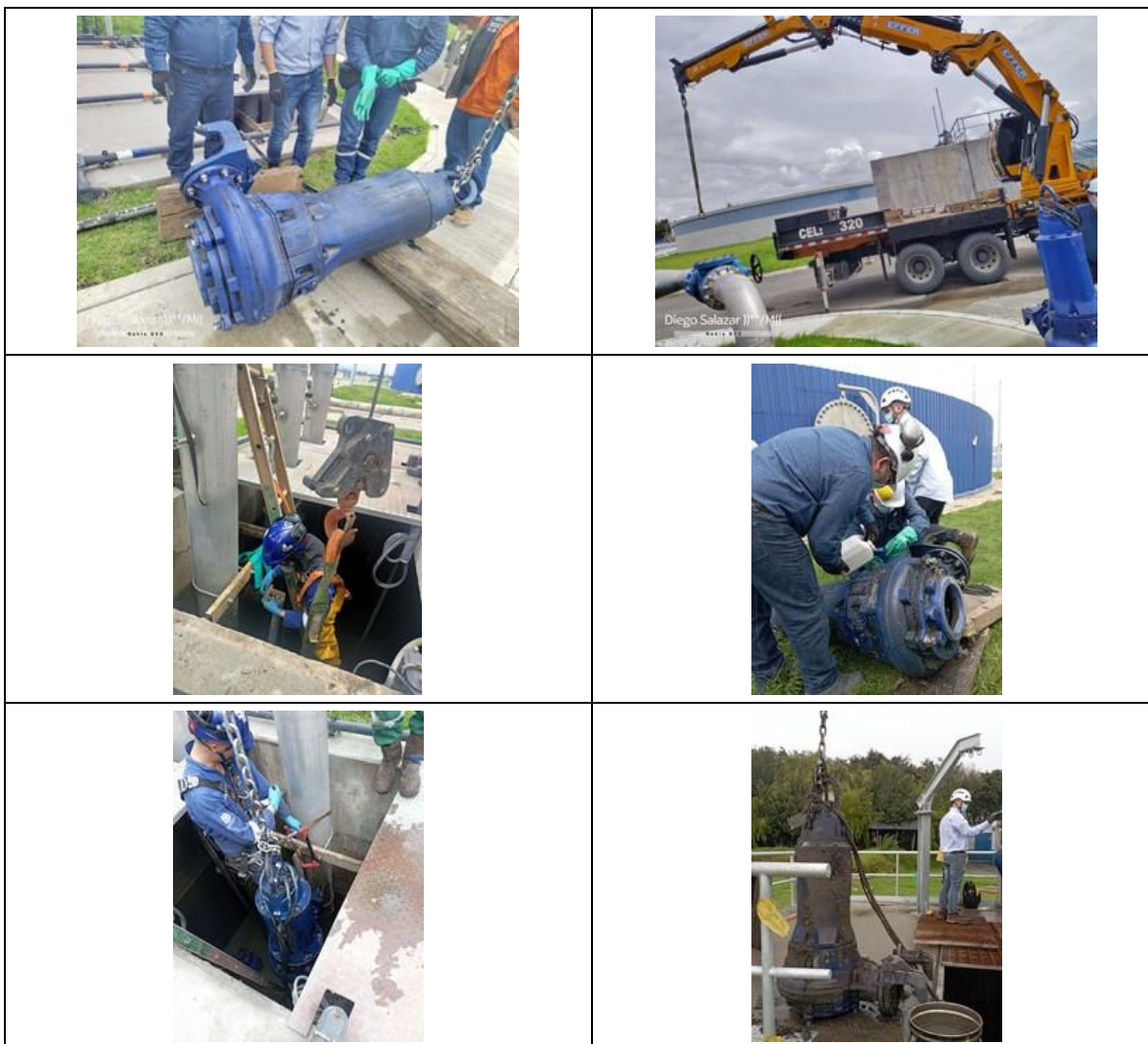
Fotografía 1. Apoyo mantenimiento Bombas de vaciado 095P101A/B/C, 095P201A/B/C, 095P501A/B/C
