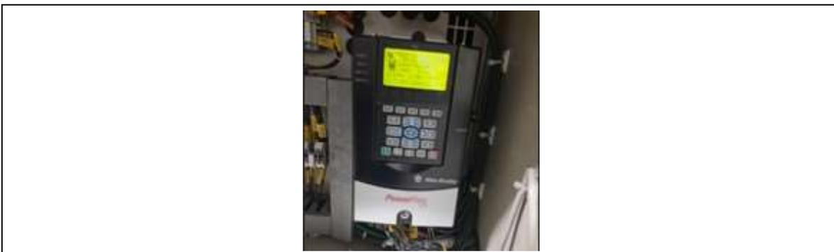
12. Al realizar la prueba mensual de electrógenos encontramos que el generador Perkins no estaba funcionando, se realizan pruebas en manual y en automático y en ningún de los dos casos el generador encendió, por este motivo desmontamos en módulo de encendido se reparó para lo cual fue necesario implementar un temporizador, se instala se hacen pruebas y queda funcionando tanto en automático como en modo manual
