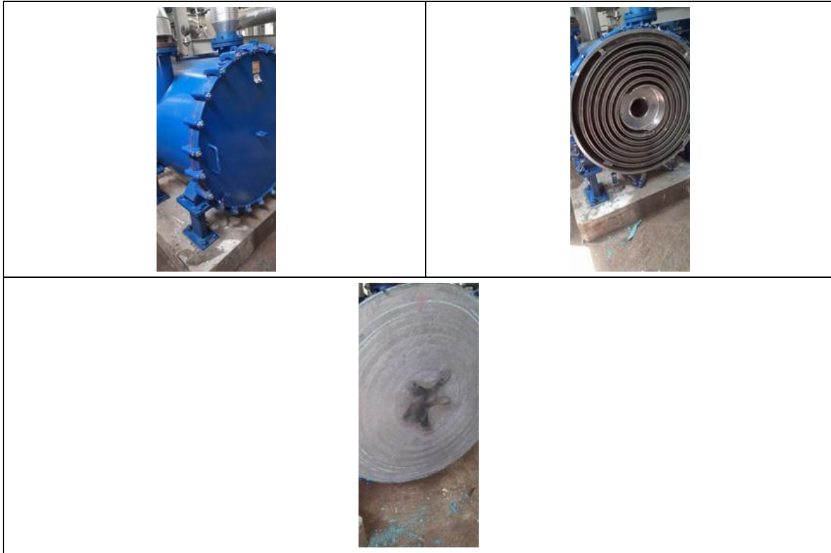
Fotografía 5. Mantenimiento Intercambiador de calor 091EI101D
