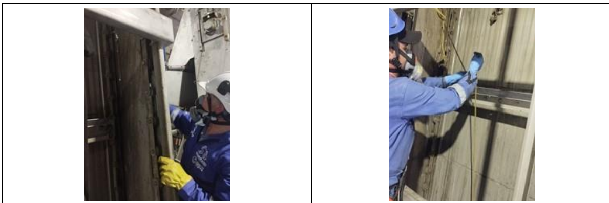
Fotografía 1. Mantenimiento rejas de gruesos válvula 051DGL001H/G
