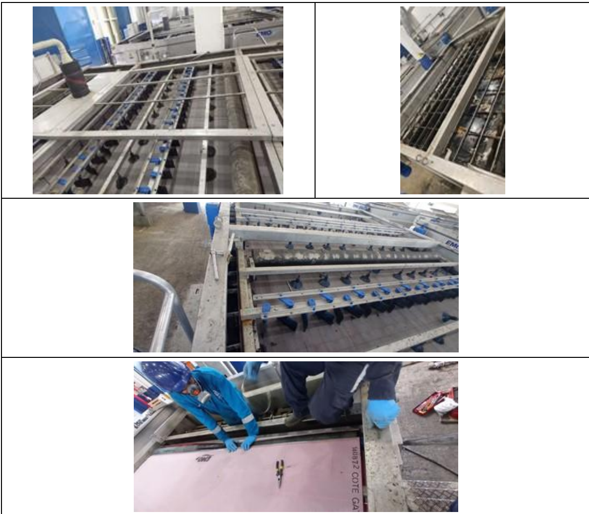
Fotografía 2. Mantenimiento mesas espesadoras 076DEPOO1B/C
