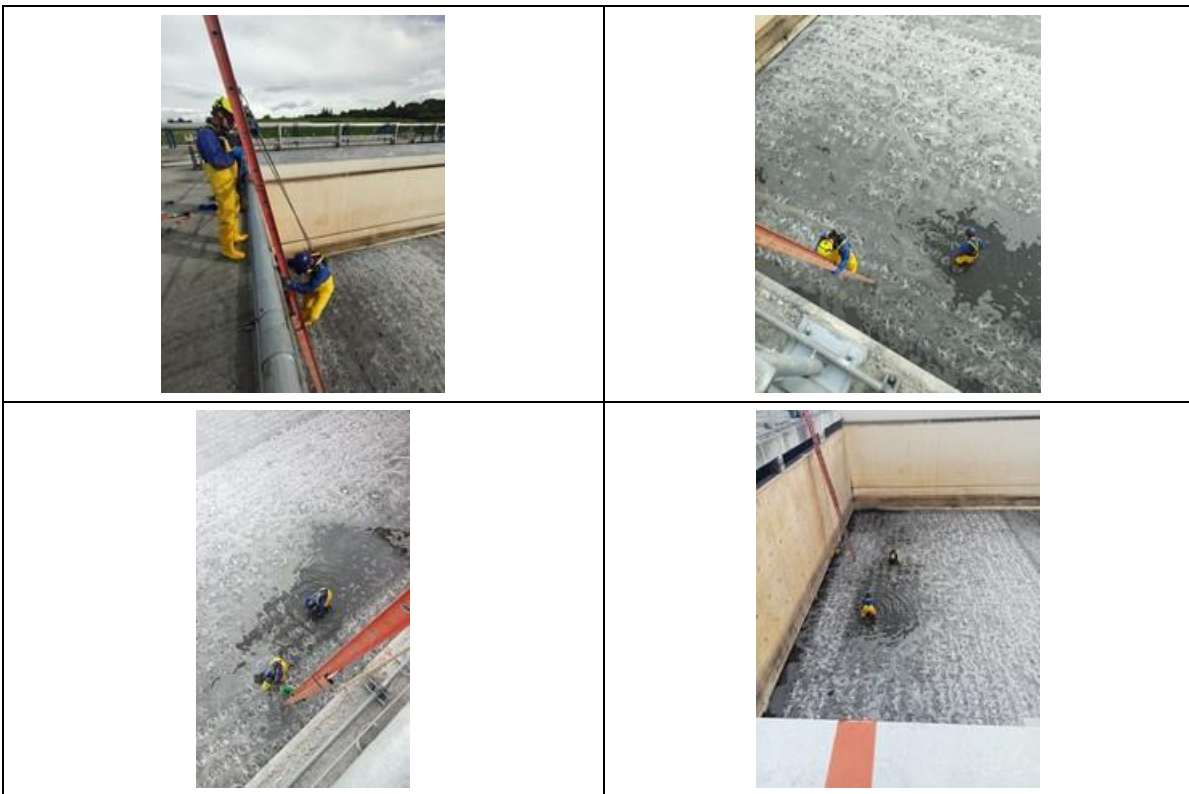
Fotografía 3. Mantenimiento balsa 5 área de lodos biológicos
