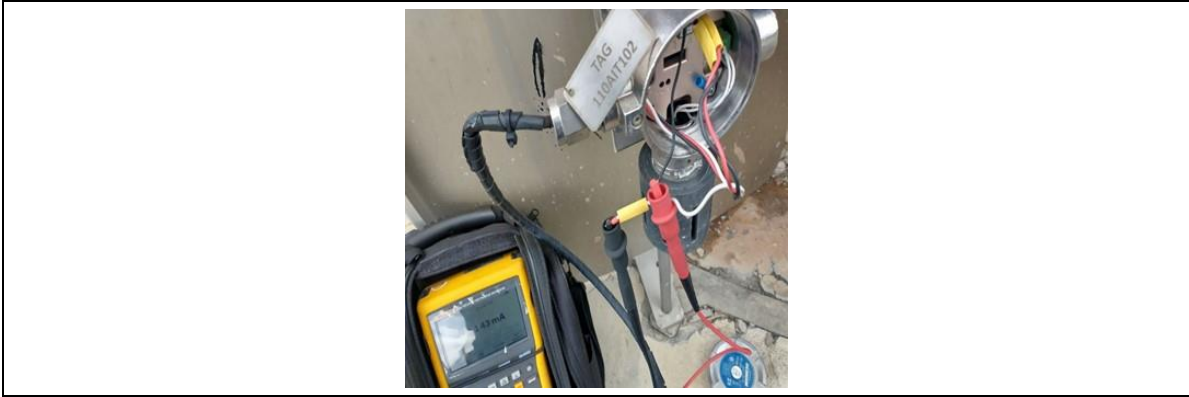
Fotografía 13. Mantenimiento sensor FSL201C
