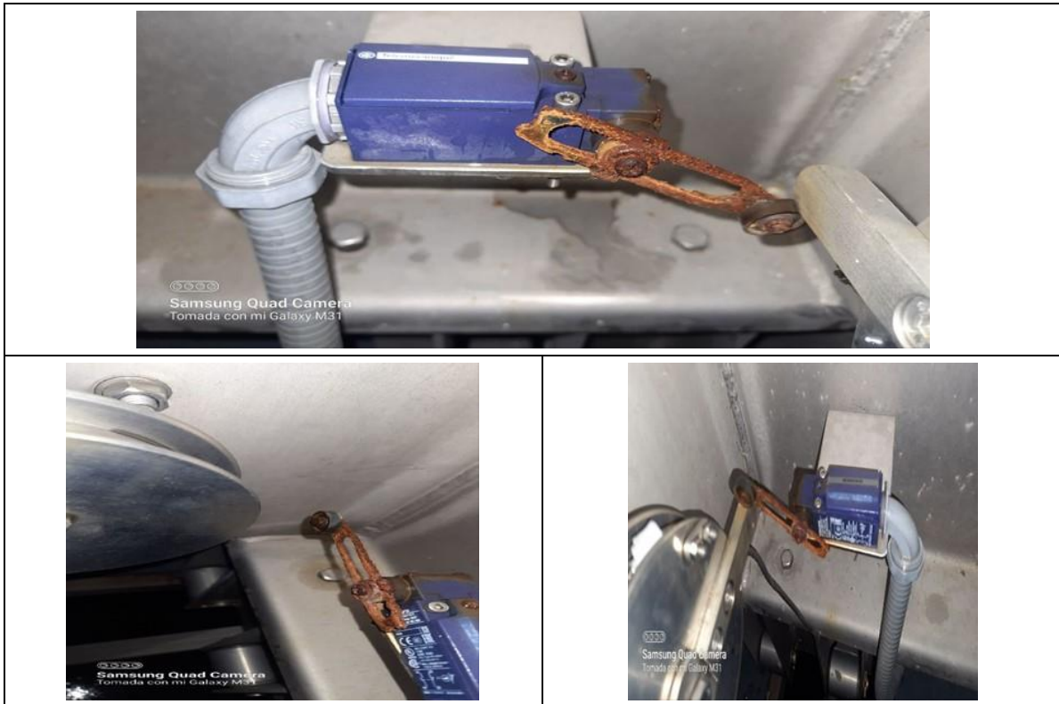
Fotografía 22. mantenimiento finales de carrera puentes desarenadores 54.1 y 54.2
