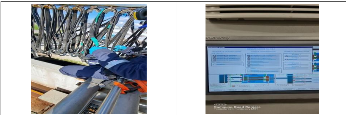
Fotografía 20. Mantenimiento cableado de control hacia tablero del CCM3 puente desarenador 54.4
