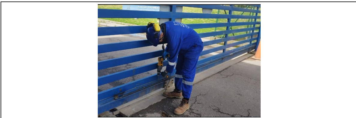
Fotografía 23. mantenimiento portería Fase I
