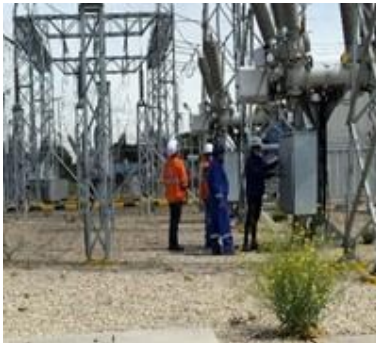
Charla sobre el manejo de la estación eléctrica al área de Mantenimiento
