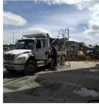
Supervisión en zonas de trabajo
