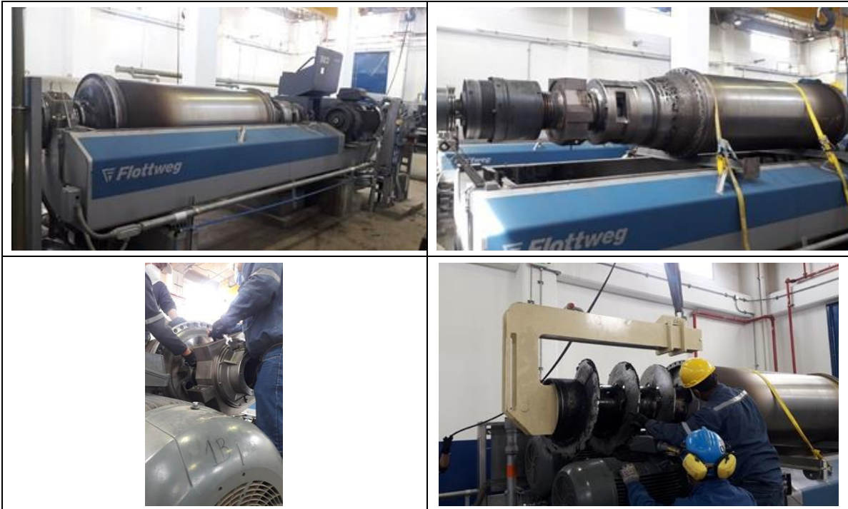
Fotografía 11. Mantenimiento Centrifugadora de lodos 073SC001B
