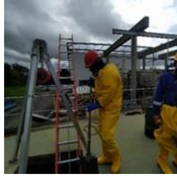
Limpieza de fosas en espacios confinados
