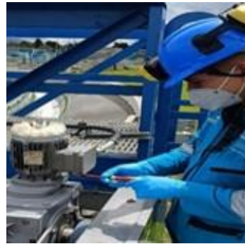
Mantenimiento de equipos
