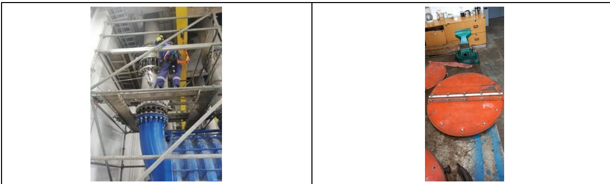
Fotografía 14. Mantenimiento preventivo del soplador de biológicos H
