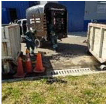
Arreglo de rejilla por parte de la EAAB
