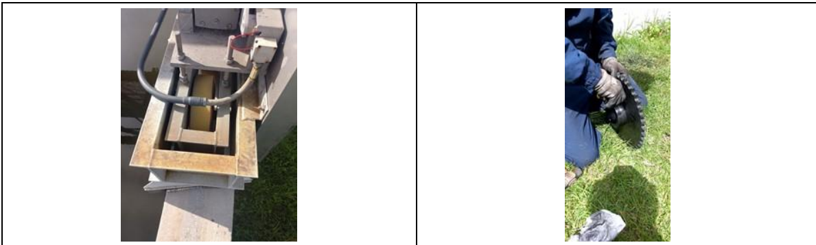
Fotografía 9. Mantenimiento Puente Clasificador 064DCL001G
