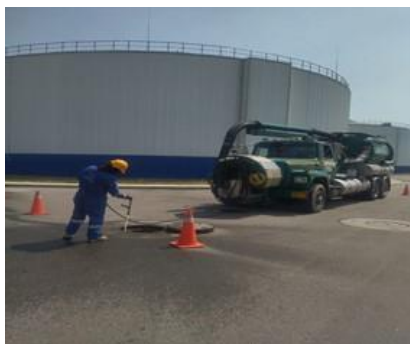
Uso de señalización en actividades sobre la vía.
