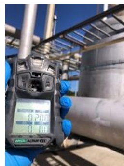
Mediciones en planta de biogás.
