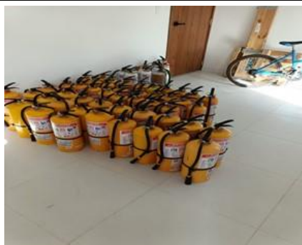
Recarga de extintores
