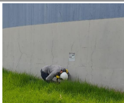
Instalación de cebaderos.
