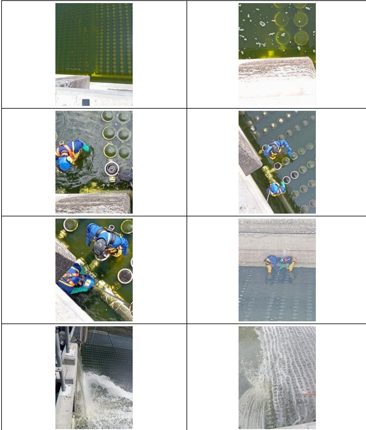
Fotografía 15. Intervención balsa # 3 área de biológicos
