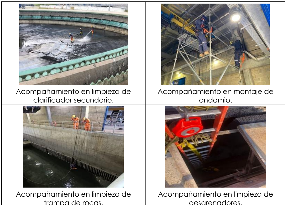
Fotografía 56. Actividades críticas ejecutadas
