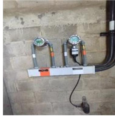
Sistema de medición constante de H<sub>2</sub>S en la zona de rejillas gruesas en pretratamiento
