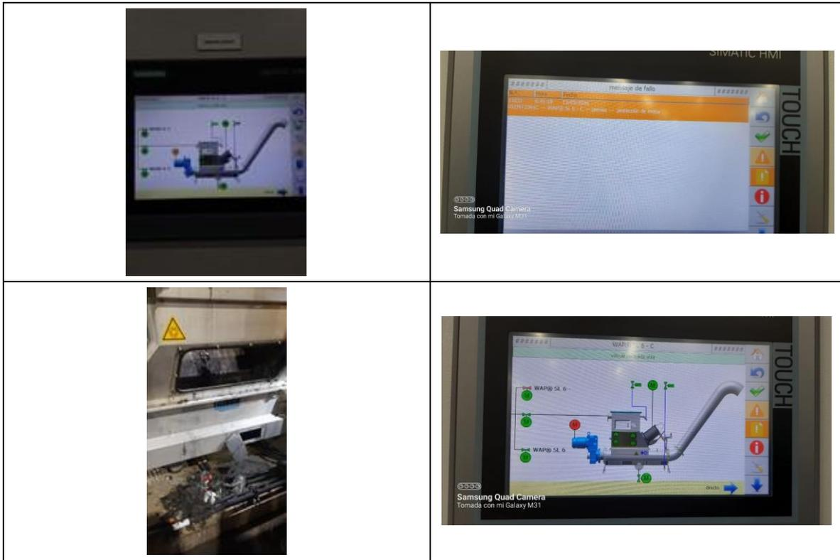
2.16 Se reporta sobrecarga en bomba spray del clarificador 64.5, se evidencia contactos disparado y se revisa el consumo de corriente marcando 5.3 A, se rearma y se deja en seguimiento, no registró novedad en el turno.
